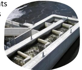
**Les dispositifs de contournement** sont souvent sous la forme d'un cours d'eau artificiel. Franchissables pour les espèces cibles, ils doivent pouvoir résister aux crues.
