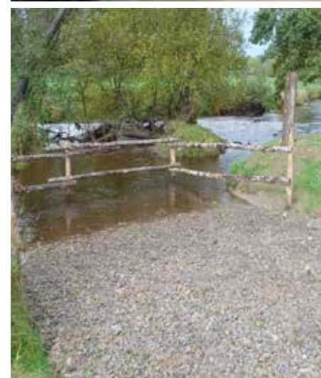
Ci-dessus, illustration de la création d'une descente aménagée en trois étapes : avant travaux (en haut), terrassement et mise en place de l'empierrement (au milieu), aménagement terminé (en bas).
