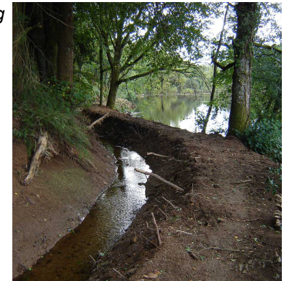
Mise en place d'une dérivation sur un étang
