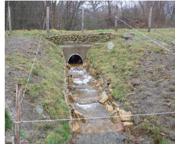
Aménagement de pré-bassins sur ouvrage routier
