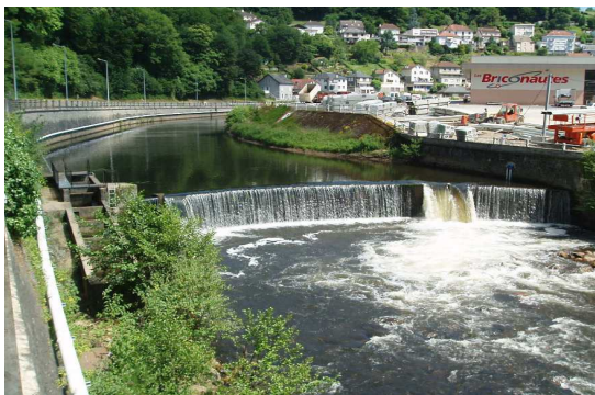
Arasement de digue à Tulle : Avant travaux
