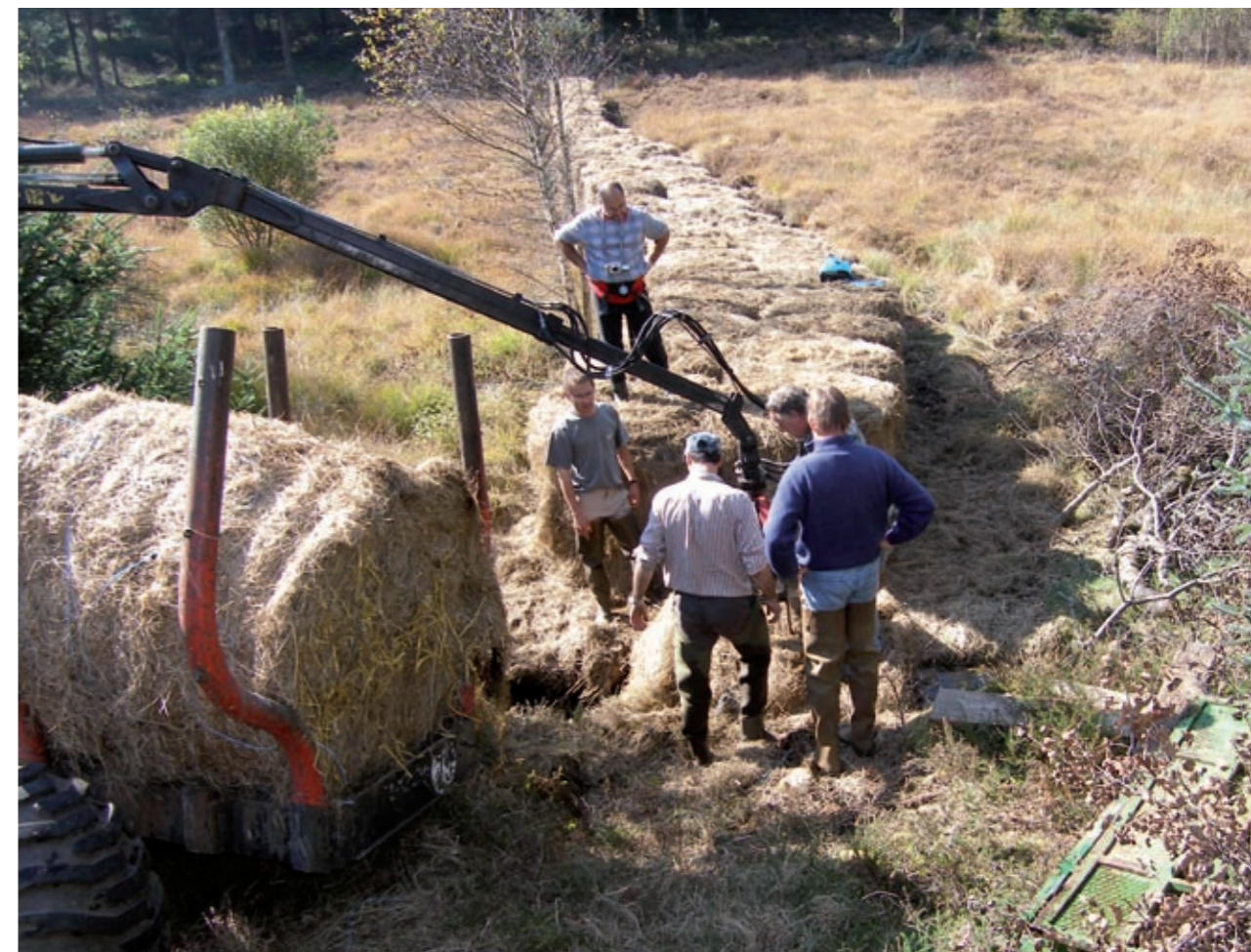
POSE D'UN BARRAGE EN BOTTES DE FOIN À L'AVANT D'UN ÉTANG POUR LIMITER LES DÉPARTS DE SÉDIMENTS LORS D'UNE VIDANGE
