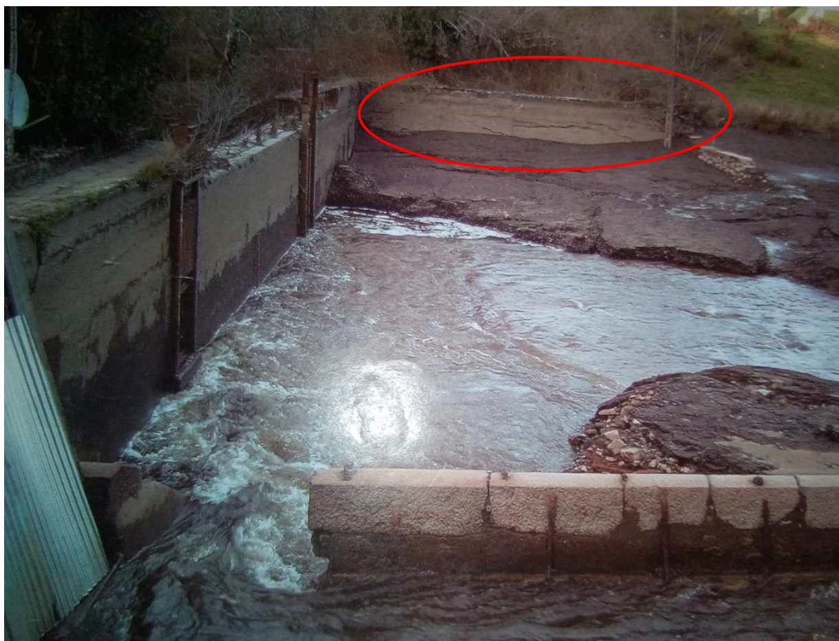
Photographie du barrage en vidange partielle avec localisation du mur à détruire
