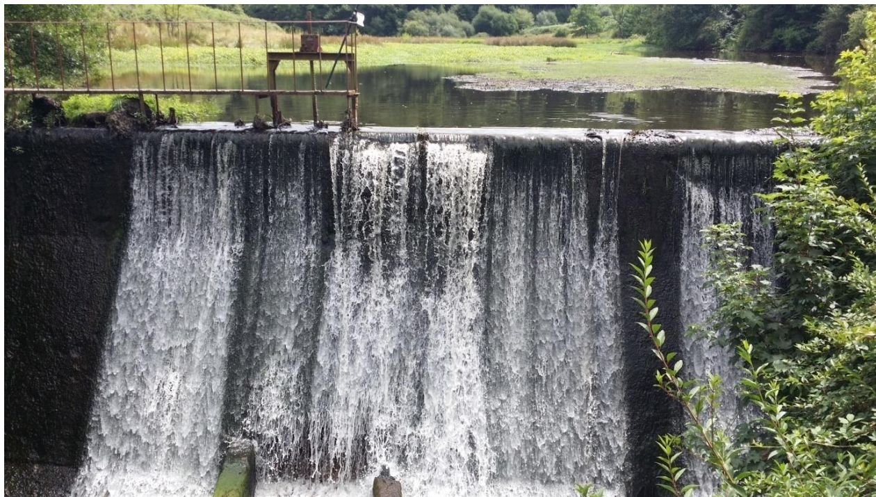
Photographie du barrage en vidange partielle avec localisation du mur à détruire
