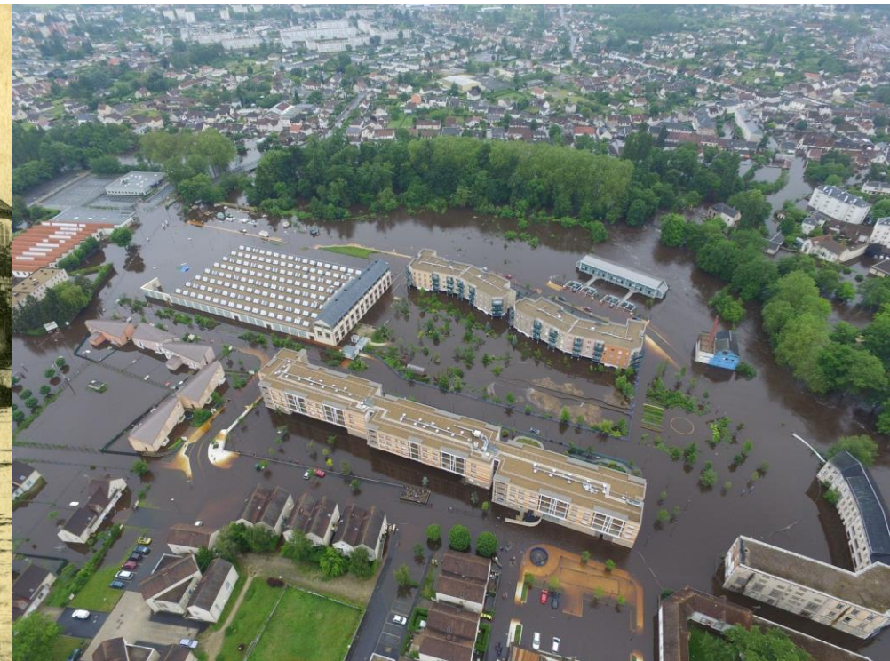
Inondation du quartier Matra - Crue mai 2016 (+1,45m)
